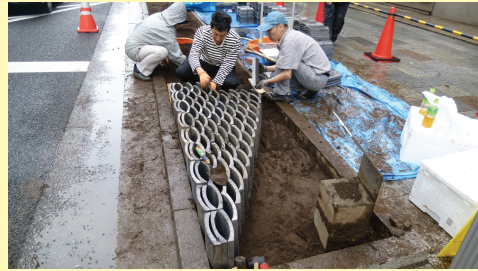
このように瓦を敷き詰めていきます。
